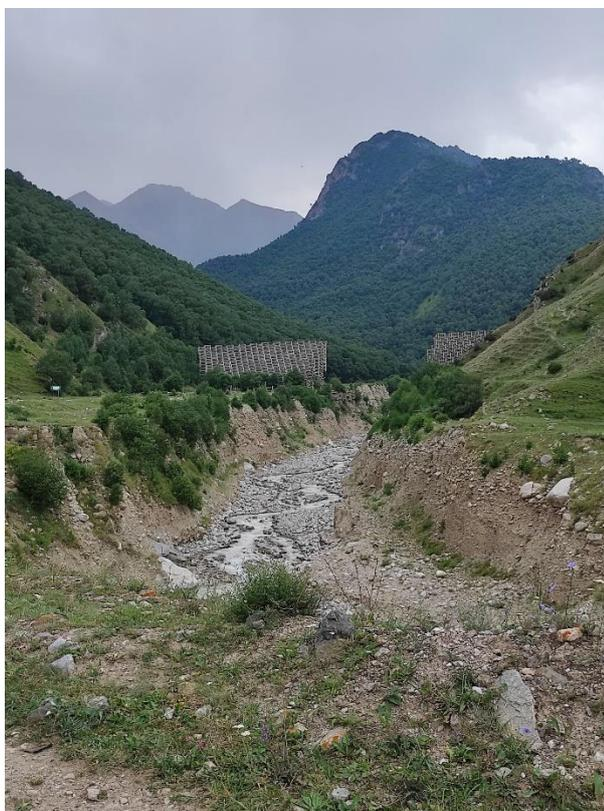
*Фото 1.2. Противоселевая дамба на р. Герхожансу была разрушена первым же селем почти сразу после постройки*
