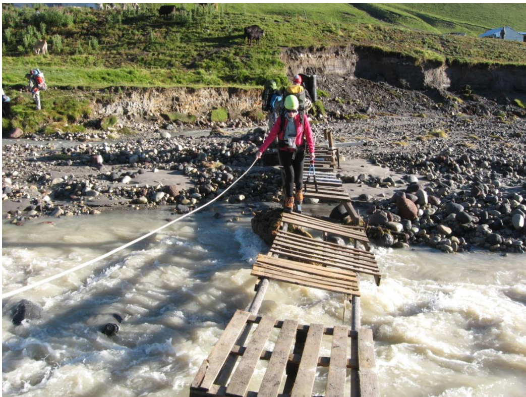
Фото 1.2 Мост через Кызылкол.
