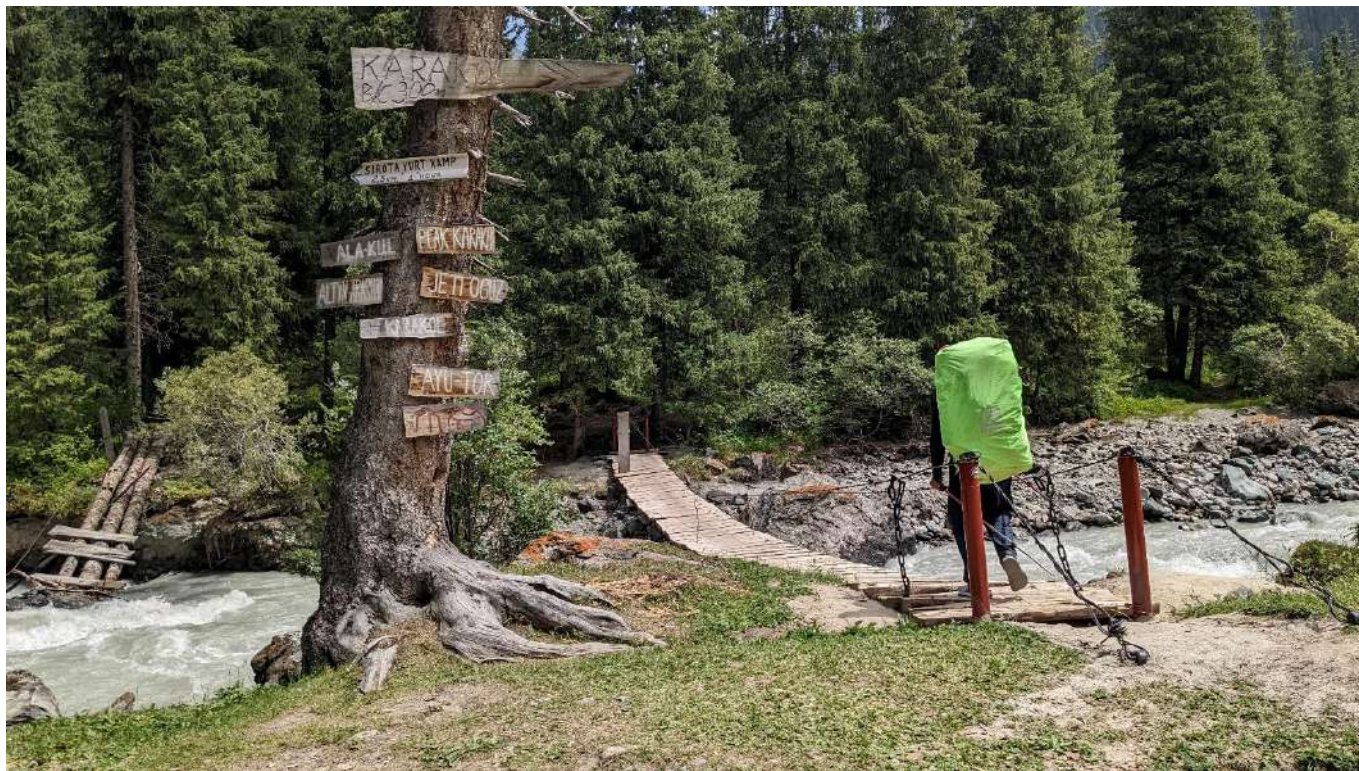
Ф.11.1 Общий вид моста через р. Каракол ниже б/л Каракол, вид с левого берега на восток
