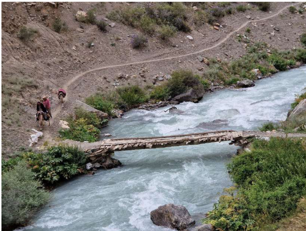
Фото 20.5 Мост на р. Арчамайдон чуть ниже впадения р. Амшут
