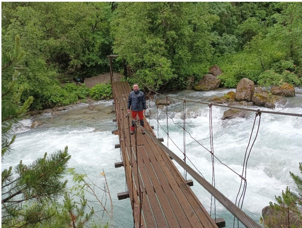
Фото 6.6. Мост через р. Махар на пути к нарзану
