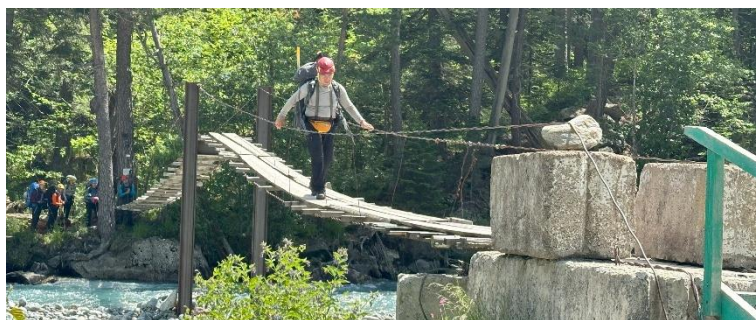
Фото 4.5. Переход подвешенного моста через р. Псыш возле погран. пункта.
