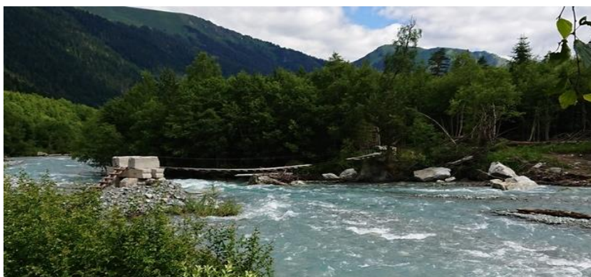
фото 16 разрушенный мост р Псыш
